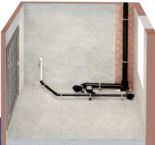
管道布局图（同层排水）
